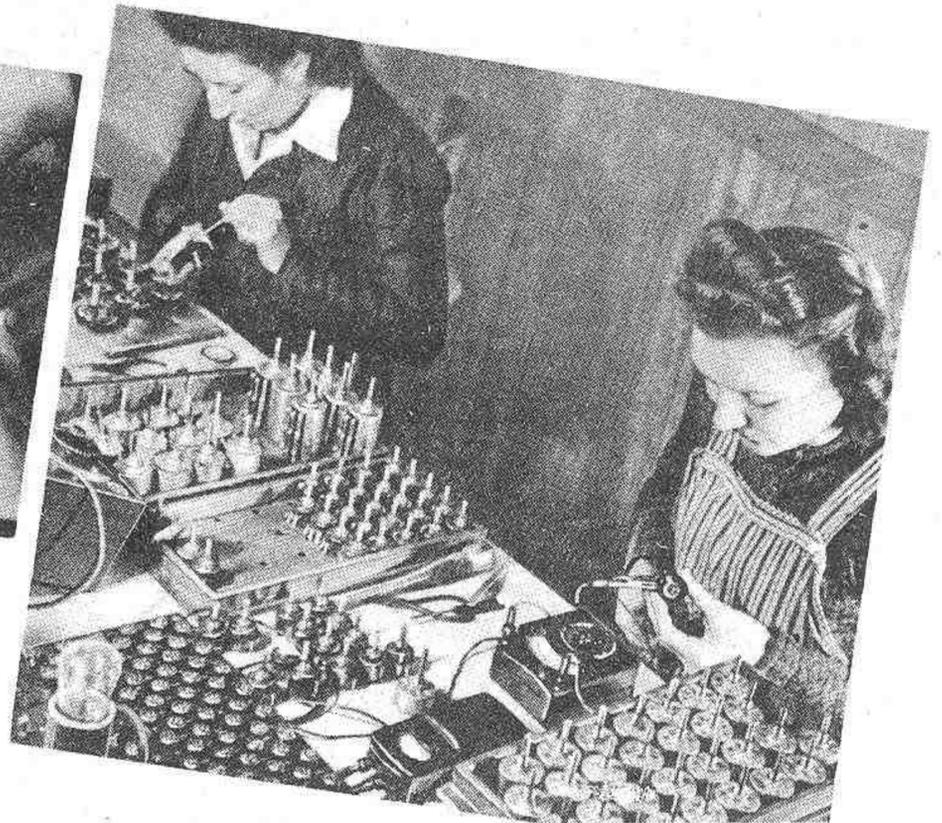
und so viele Stanz-, Schneid-, Biege-, Dreh-Bohrschablonen, Montage-Werkzeuge usw. Herstellung von Schaltern und Potentiometern. Der Schalterbau ist Vorrichtungsbau. Allein der Aufbau eines Schalters K 2500 benötigt man. Der Aufbau eines Schalters K 2500 benötigt man. Der Aufbau eines Schalters K 2500 benötigt man.
